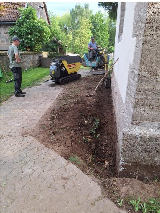
Am 15. Mai haben Martin und Felix Keller zusammen mit Heinz Kellermann einen Graben für Drainerohre um die Ohrenbacher Kirche ausgehoben. So wird die Feuchtigkeit an den Außenwänden eingedämmt.
